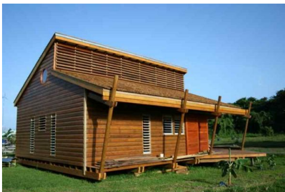
Figure 59 : Exemple de toiture réalisée en tuiles de bois de châtaigniers (Villa bois Guadeloupe 2007, photo : La Tuile de Bois SOVECO)
