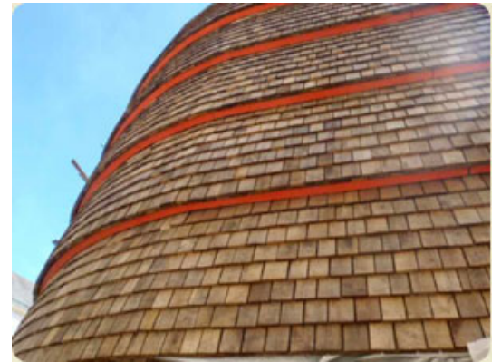
Figure 58 : Exemple de toiture réalisée en tuile de bois (photo : La Tuile de Bois SOVECO)
