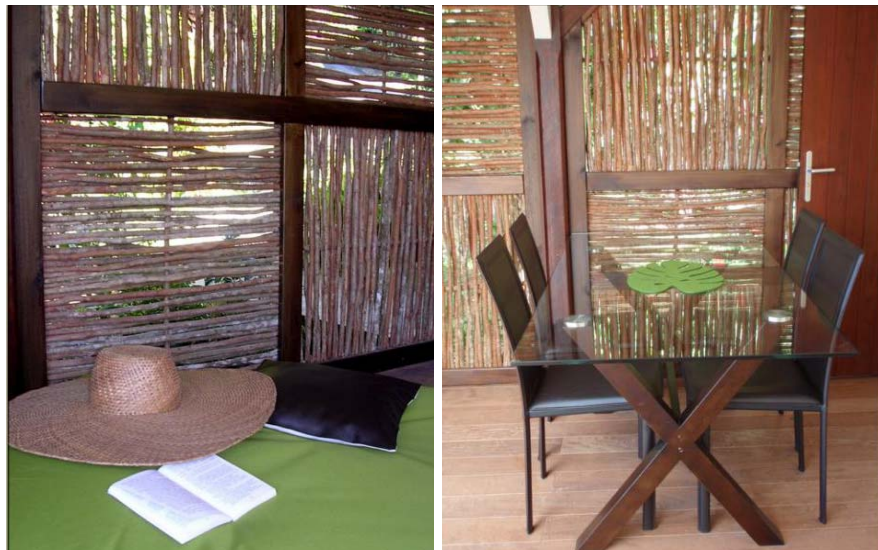
Figure 14: Paroi extérieure en gaulette (source J. VERMEIRE)
