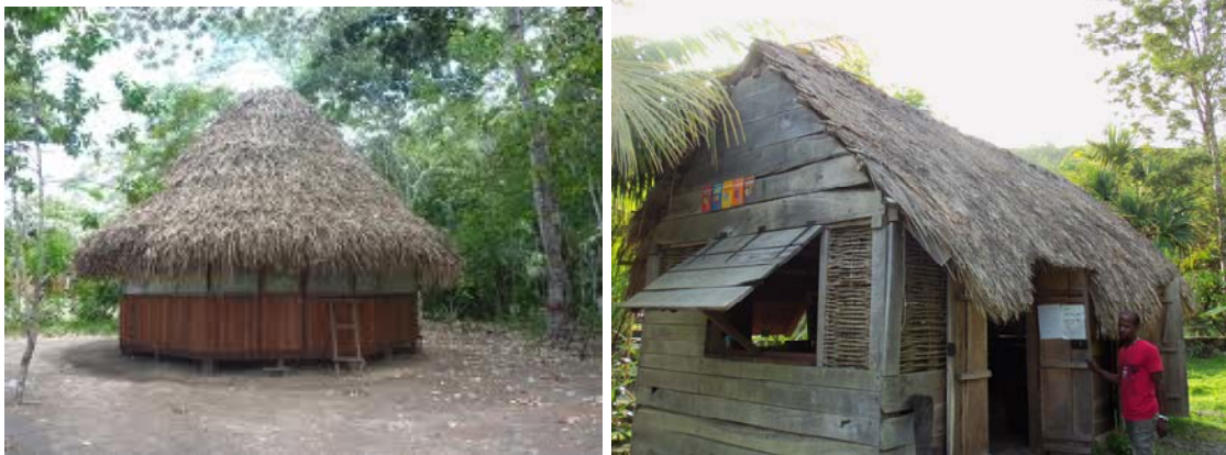
Figure 64: Photo de case avec toiture en feuilles de palmier (à gauche) et feuille de canne (à droite) (source : Savane des esclaves ; photo : Caraïbes Environnement)
