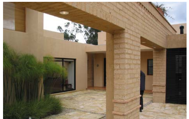
Figure 18 : Exemple de construction réalisée en brique de terre crue comprimée (photo Tierratec)
