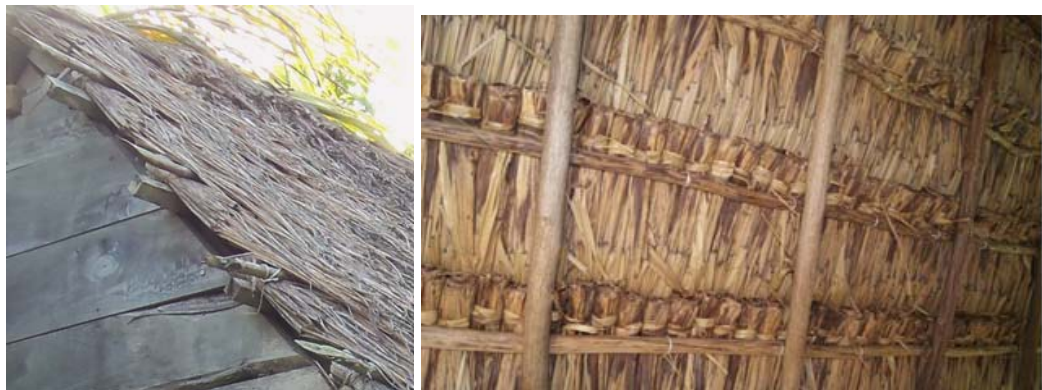
Figure 68: Pose des bouchons (source : La Savane des esclaves, photo : Caraïbes Environnement ; école Algues Marines)
