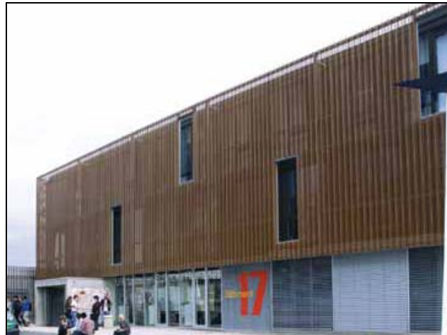
Figure 12 : Illustration de l'utilisation d'une protection de façade en bois pour un bâtiment scolaire
