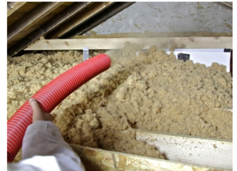
Figure 40 : Illustration du soufflage de l'isolant (photo : ACTIS)
