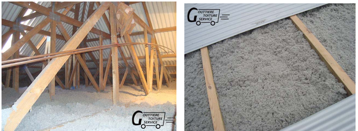
Figure 34 : Isolations de toitures en ouate de cellulose (Image GTS Martinique)
