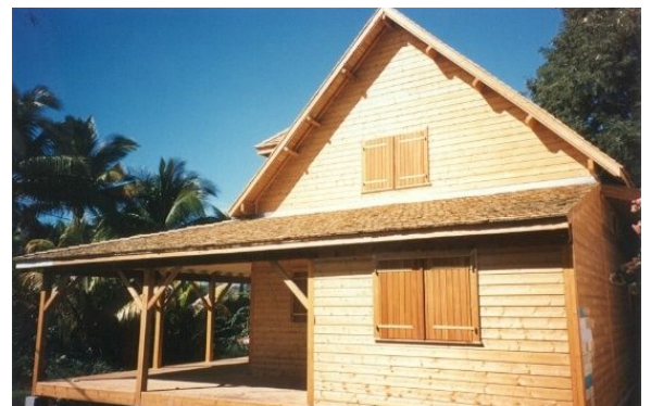
Figure 60 : Exemple de villa et toiture en bois (Guadeloupe 2006, photo : La tuile de Bois SOVECO)
