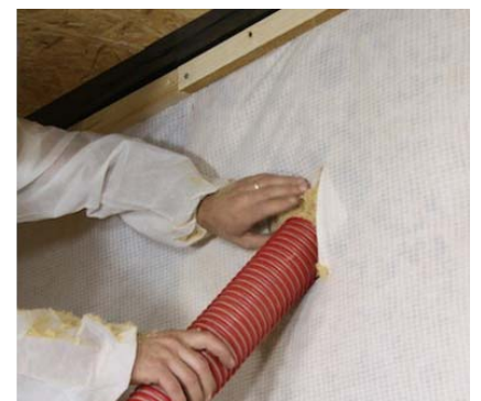
Figure 41 : Illustration de l'insufflation de l'isolant (photo : ACTIS)
