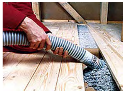
Figure 59: Soufflage de ouate de cellulose humide
