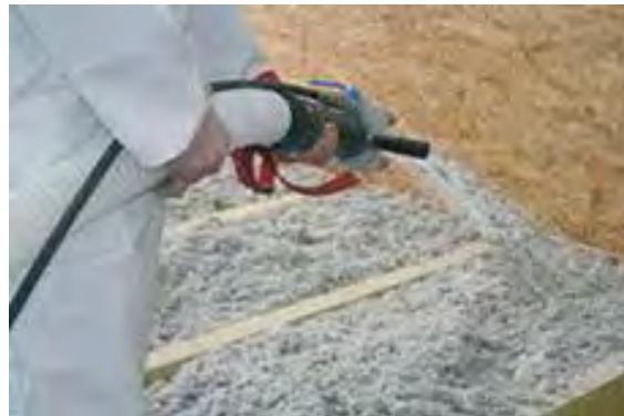
Figure 57: Soufflage de ouate sèche en surface horizontale
