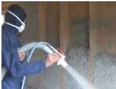
Figure 59: Soufflage de ouate de cellulose humide
