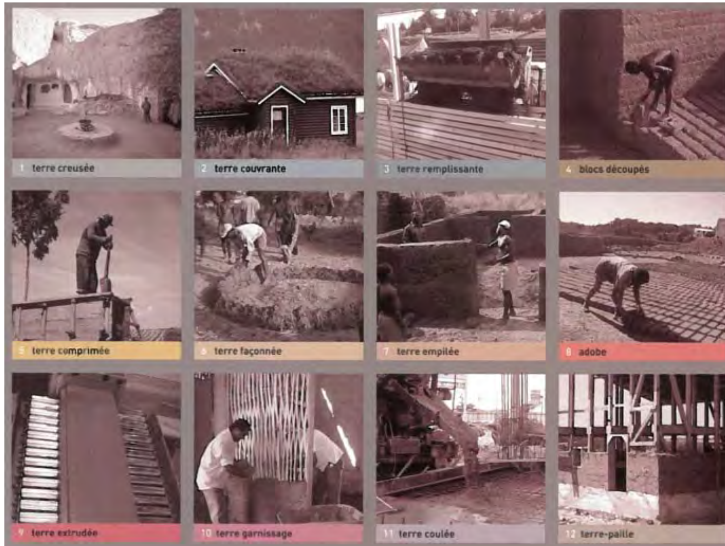
Figure 24 : Différents modes d'utilisations de la terre pour la construction (source : CRATERRE)
