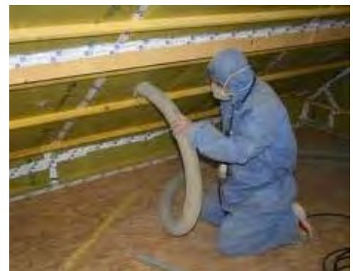
Figure 58: Soufflage de ouate sèche en volume fermé
