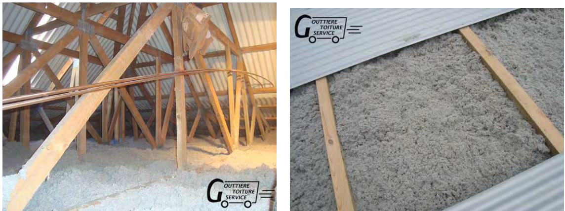
Figure 56 : Isolations de toitures en ouate de cellulose (Image GTS Martinique)
