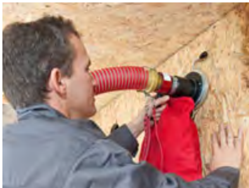
Figure 58: Soufflage de ouate sèche en volume fermé
