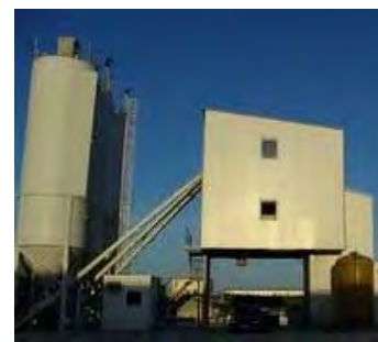
Figure 55 : Usine à béton (100 m 3 /h – env. 200 000 €)
