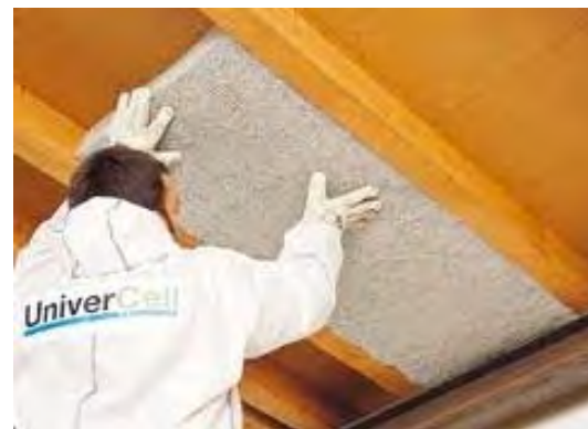
Figure 60: Pose de laine et de panneaux en ouate de cellulose
