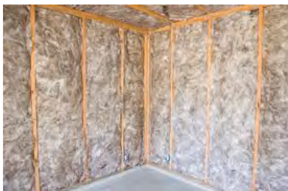
Figure 60: Pose de laine et de panneaux en ouate de cellulose
