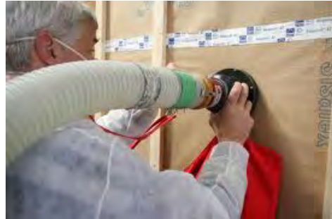
Figure 12 : Soufflage d'isolation jasmin en volume fermé, www.batilux.com
