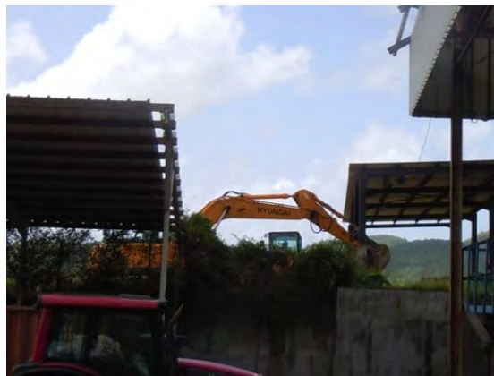
Figure 40 : aire de stockage du « village de la poterie des 3 ilets »
