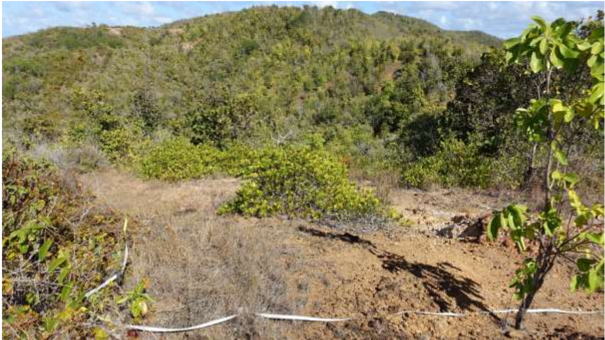
Photos 3 ci-dessus : vue du versant nord de la réserve (juste au nord du château Dubuc), faisant face à la zone d'érosion n°5. Elle montre le fort taux de défoliation/mortalité de la forêt ainsi que d'autres zones d'érosion en cours d'extension gagnant la pente depuis la crête.
