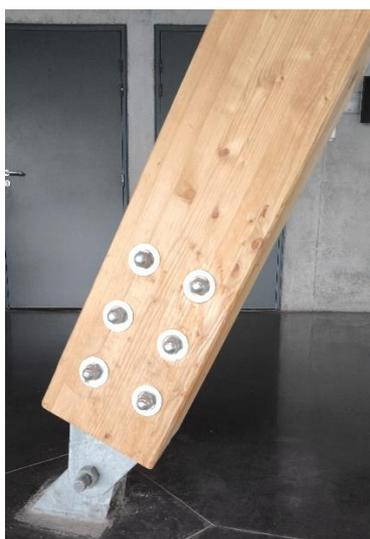
Figure 57 : Assemblage en pied de poteau
